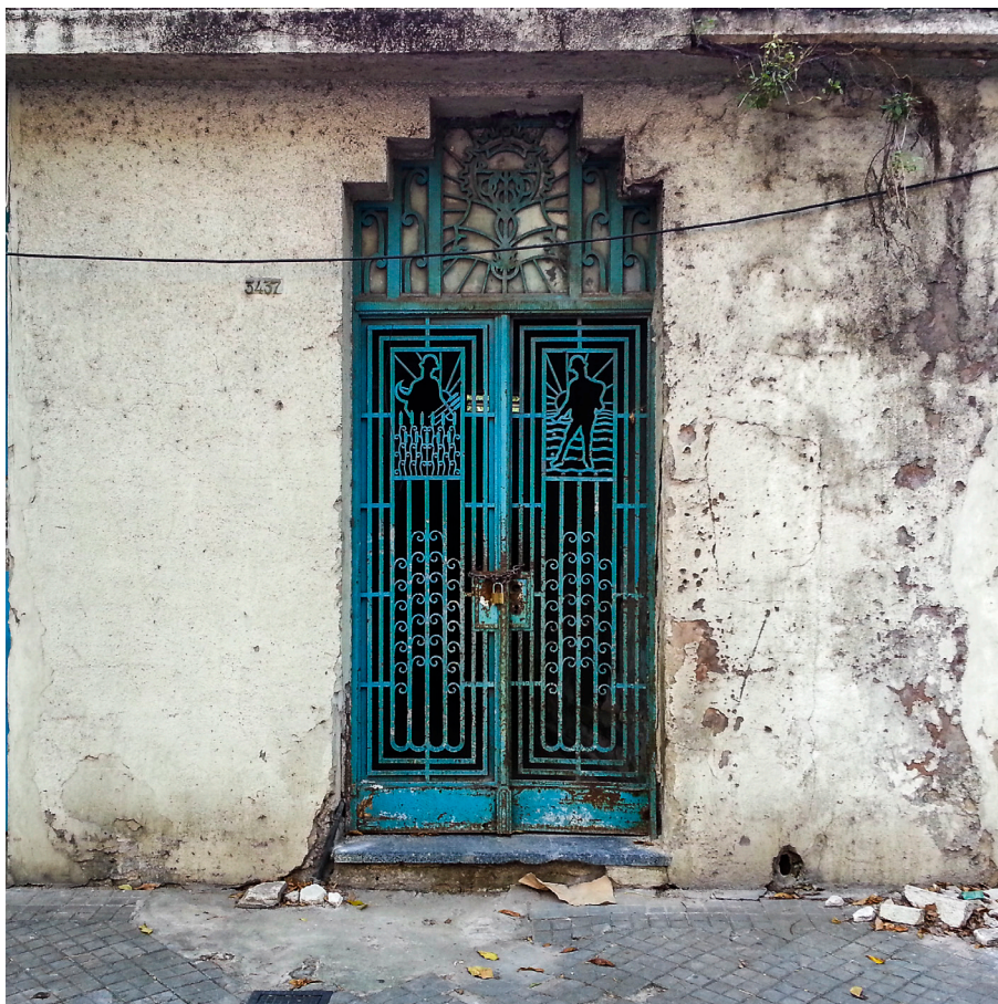
Fachada en calle Maipú 3437. Rosario. 2014. Proyecto "Fachadas de Rosario". © Arquitecto Walter G Salcedo. @arqwgs
